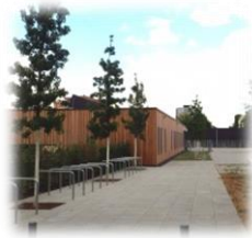
Riegelhofkita am Campus
